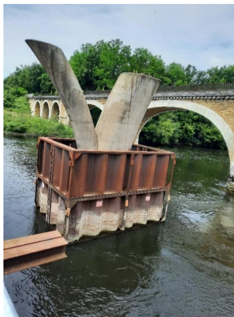
Détail de construction d'une pile de pont routier en parallèle à la voie SNCF
