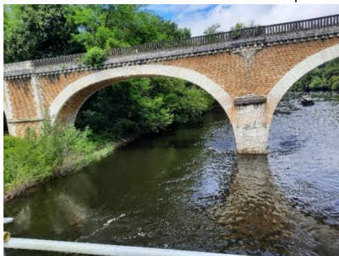
Pont de la ligne SNCF adjacent à celui du projet
