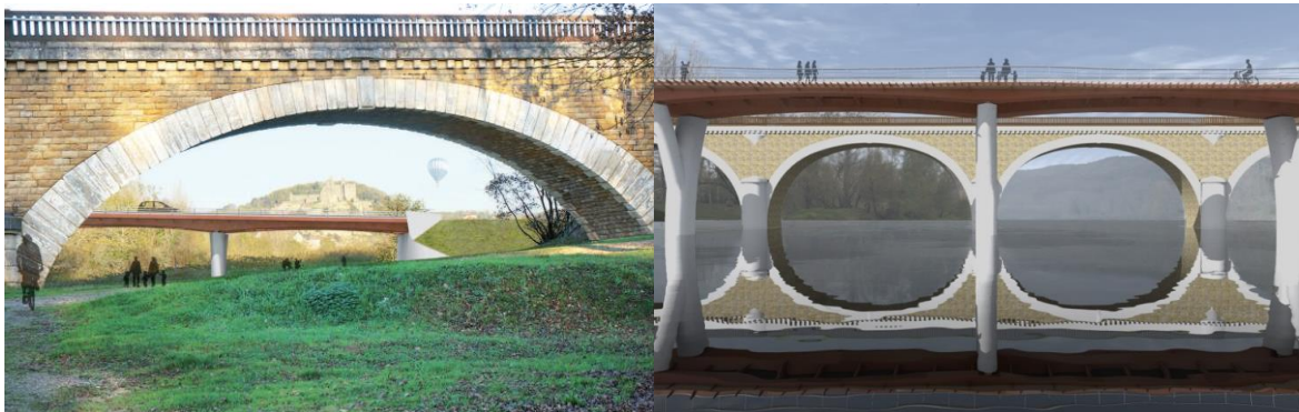
Ouvrages du Pech et de Fayrac
