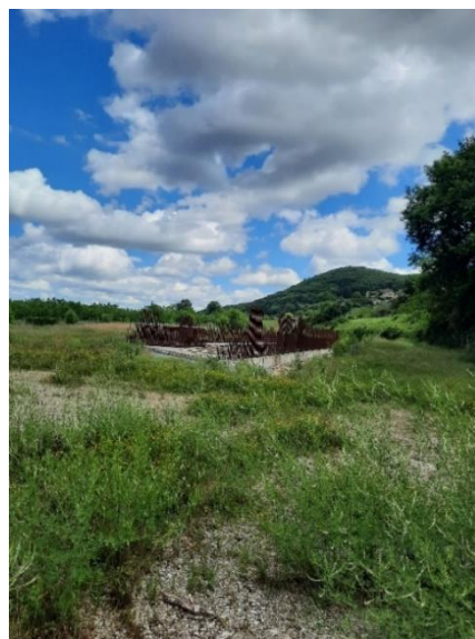
Radier du pont rail des Milandes
