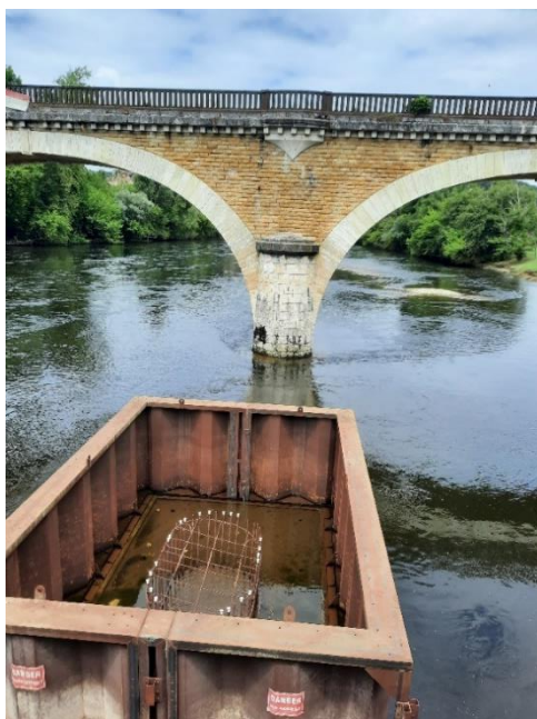
Détail de construction d'une pile de pont routier en parallèle à la voie SNCF
